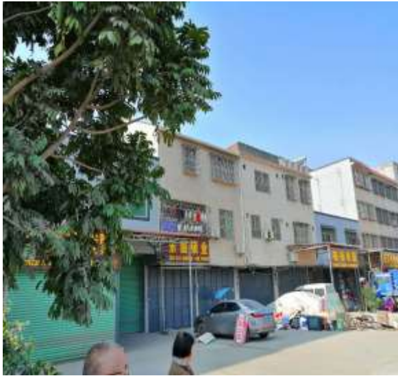
项目东北面商住楼
