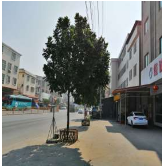
项目西南面商住楼
