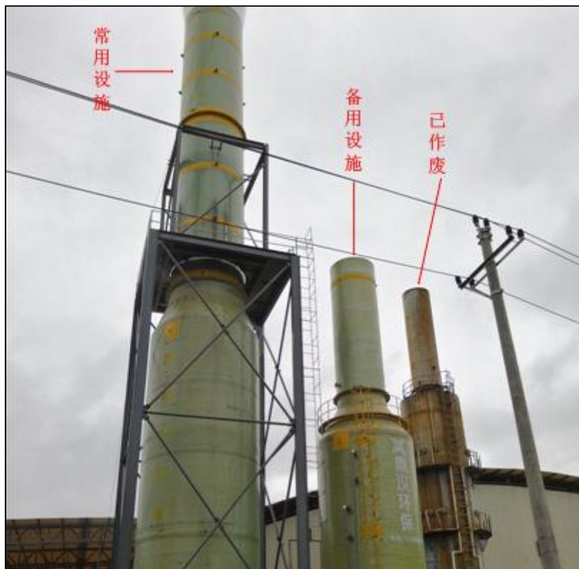
图 4.2-2 钠碱双碱法脱硫除尘设备现场照片
