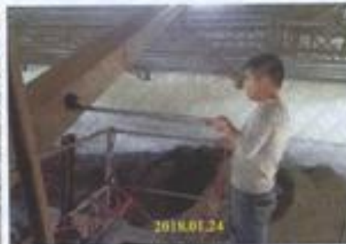
布袋除尘设备排气筒
