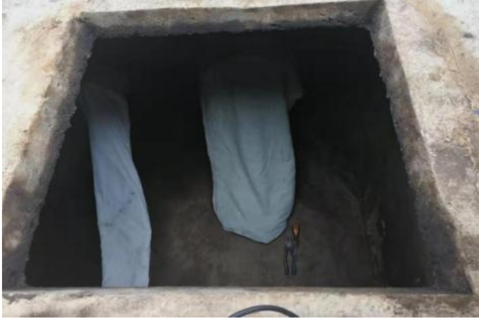
图 4.2.1 布袋除尘器装置
