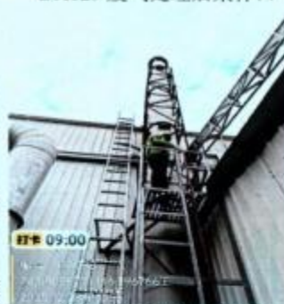
DA033 废气处理后采样口
