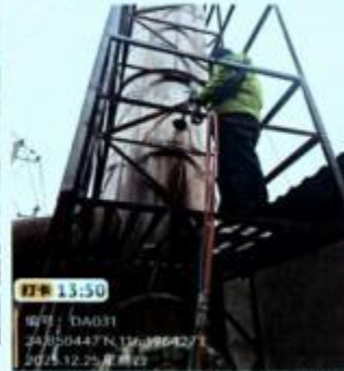
DA031 废气处理后采样口
