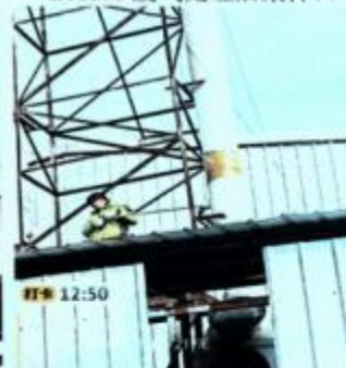
DA023 废气处理后采样口
