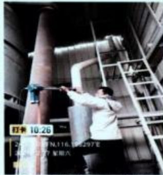
DA029 废气处理后采样口
