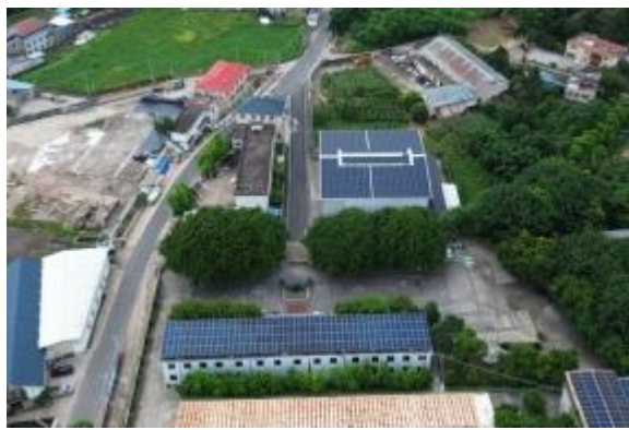
本项目西侧——广东固特超声股份有限公司办 公楼与停车场
