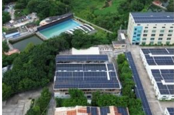
本项目北侧——广东固特超声股份有限公司空 置厂房
