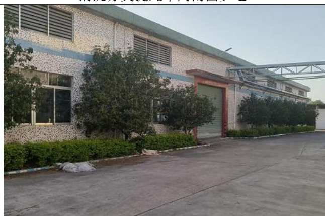
改性造粒车间北面厂房
