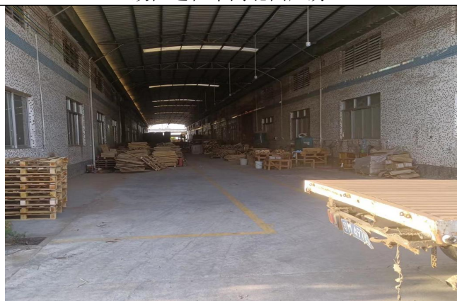
改性造粒车间西面厂房通道
