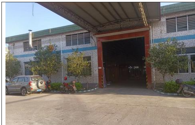
清洗分类提纯车间东面、改性造粒车间南面厂房
