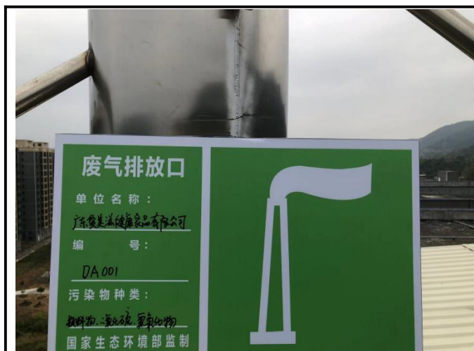
废气排放口标识
