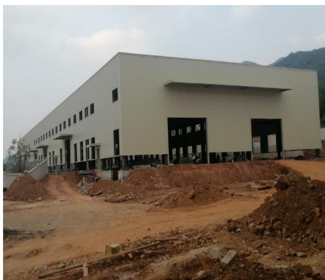
项目北面空置 1#厂房
