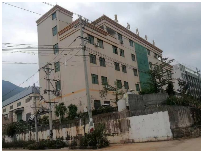
项目南面广东穗森实业有限公司（蕉润甘泉）
